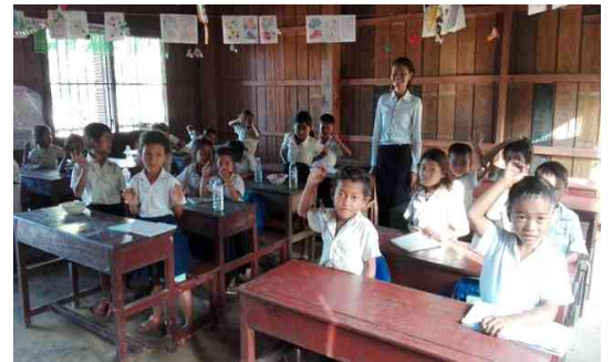
写真 上：工事中の小学校 下：補修工事後の教室
